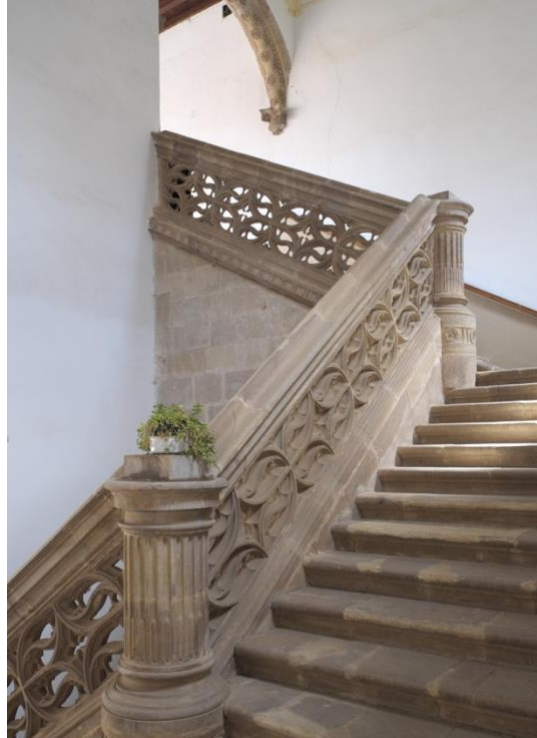
Escalera del Convento de La Asunción.
